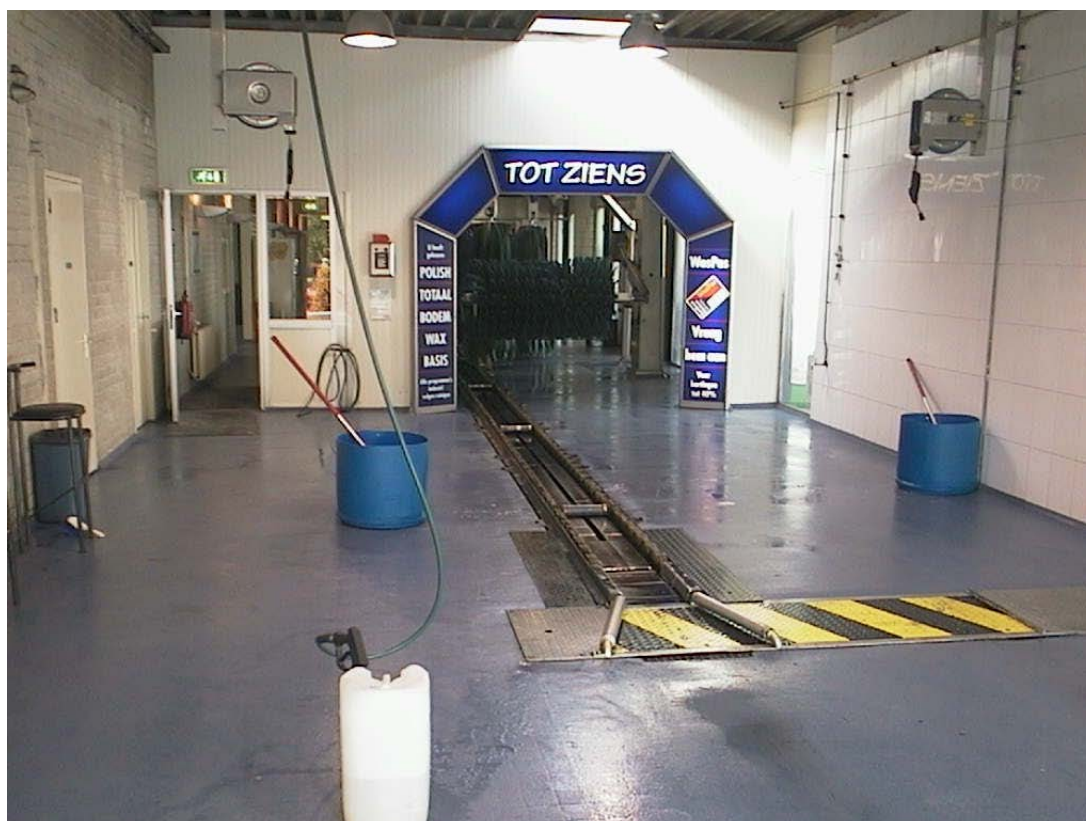
Foto: Voorbeeld te inspecteren vloeistofdichte voorziening.
