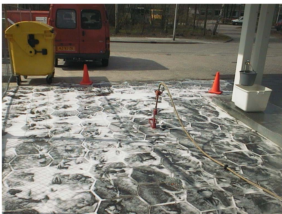
Foto: Inspectie uitgevoerd overeenkomstig protocol 6704.
